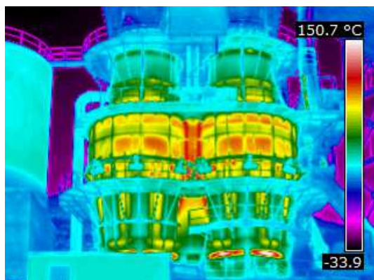
Verifica stato del refrattario in una fornace per la produzione di calce.
